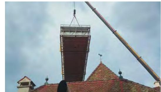
Les installations doivent être aisément accessibles (extérieures) afin d'y installer la grue utilisée pour le déchargement et la mise en place du spa ou de la piscine à son emplacement définitif.
